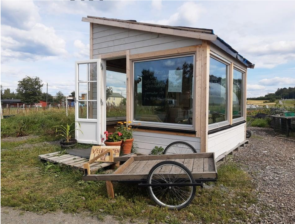
Her er et eksempel på en utsalgsbod bygget av gjenbruksmaterialer som en del av utdanningen for byggfagarbeidere på Skjetlein videregående skole i Trondheim. Foto: Framtiden i våre hender.
